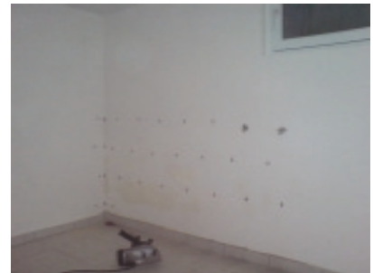
Bohrungen für eine Porofin-Flächensperre Bild 3
