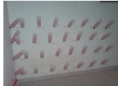
Injektionen für die Porofin-Flächensperre Bild 4
