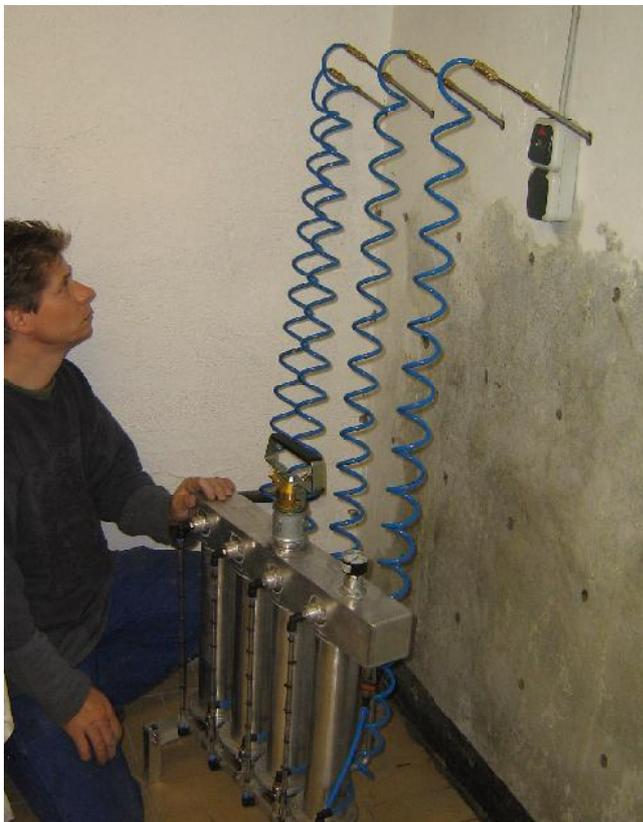
Porofin-Dosimat 4 im Einsatz bei der Erstellung einer Porofin-Flächensperre gegen Querdurchfeuchtung wegen fehlender vertikaler Aussenabdichtung. Eine bituminöse Aussenabdichtung war wegen der dortigen Garage nicht möglich.
