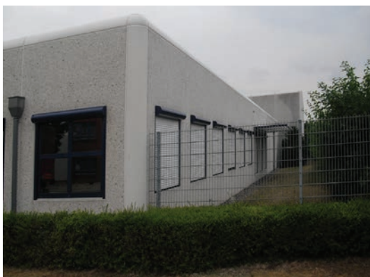
Büro- und Fabrikgebäude in Lübeck
