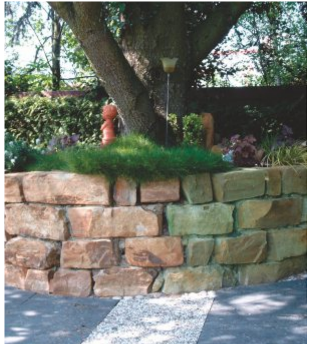
Natursteinbeet: Rechts vergrünt, links mit Lotuclean gereinigt und mit Lotupor imprägniert.
