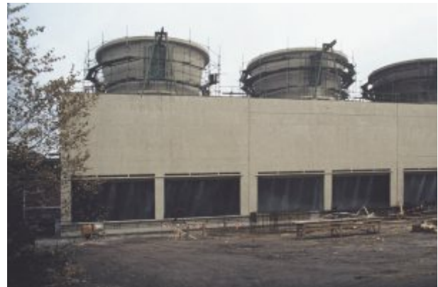
Betonsanierung an Block-Kühltürmen, unten fertig, oben in Arbeit
