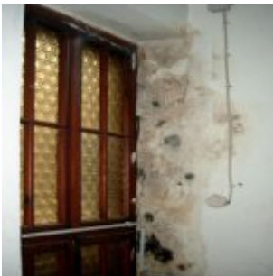
Bild links vor der Behandlung mit Porozid-Antischimmel-Spray, mit deutlichen schwarzen und braunen Verfärbungen im Feuchtigkeitsverlauf.
