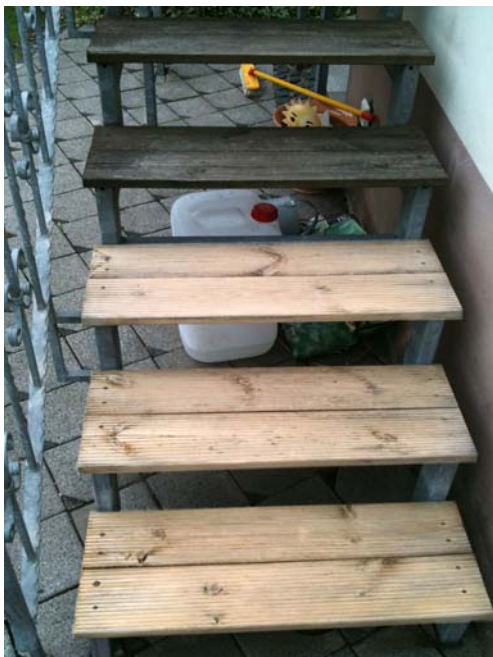
Holztreppe teilweise gereinigt mit LotuClean SF. Einwirkungszeit ca. 30 Minuten.
