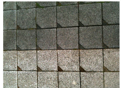
Gehwegpflaster, oben: verschmutzt, unten: mit LotuClean SF gereinigt (Einwirkungszeit 15 Minuten und nachgespült).
