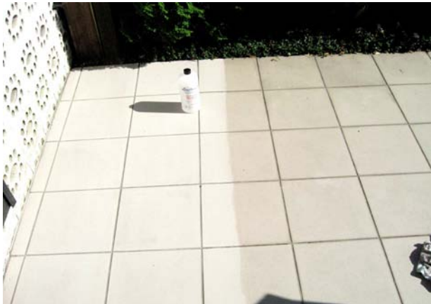
Die linke Testfläche der „sauberen“ Terrassenfliesen wurde mit einem Wischtuch und LotuClean SF abgewischt und mit einem trockenen Tuch nachgeputzt.
