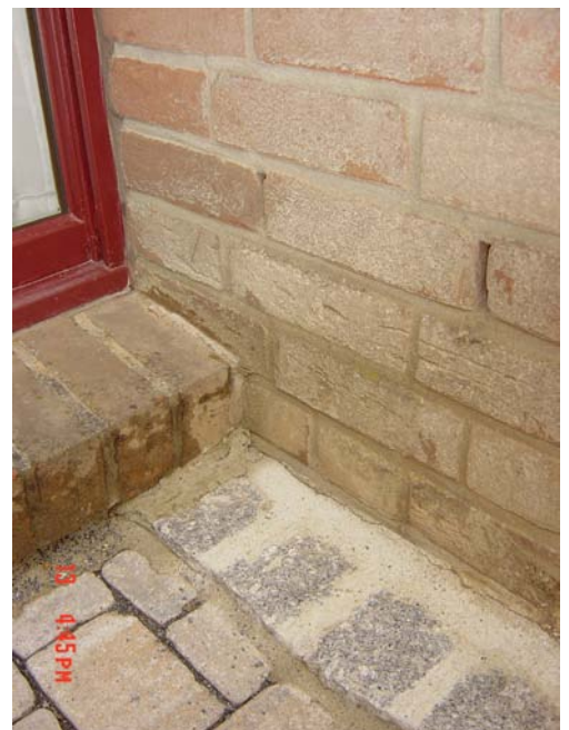
Das Sichtmauerwerk nach LotuClean A-Reinigung
